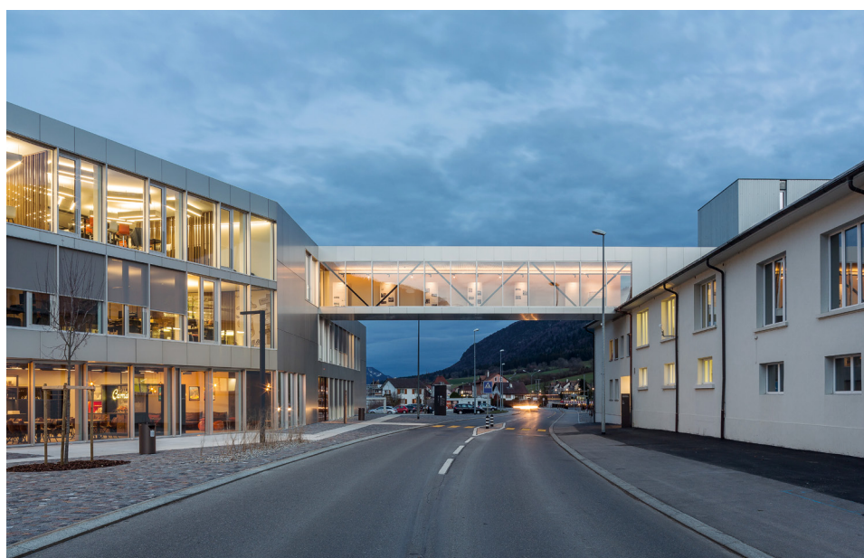
Entre l'isolation des premiers bâtiments de Camille Bloch, à droite, et les exigences appliquées à ceux inaugurés en 2017, l'ensemble du site répond désormais quasiment aux normes Minergie.
